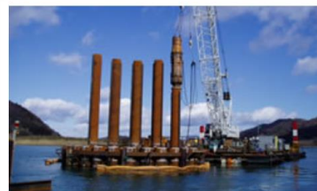
宮城県 北上川橋下部φ1000mm鋼管杭打設 (150t吊クレーン台船) (出典:松原建設ホームページ)
