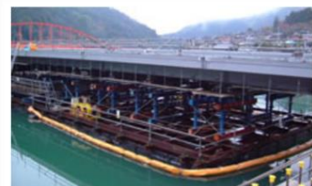
熊本県 百済来橋架設 (桁受作業台船) (出典:松原建設ホームページ)
