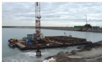
福岡県 新北九州空港土砂掘削 (1m3グラブ台船) (出典:松原建設ホームページ)
