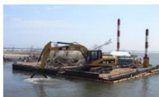
宮城県 貞山運河瓦礫撤去 (災害復旧,0.7m3/バックホウ台船) (出典:松原建設ホームページ)
