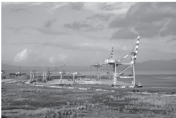
図1 バタンガス港の状況 (2011) 年
