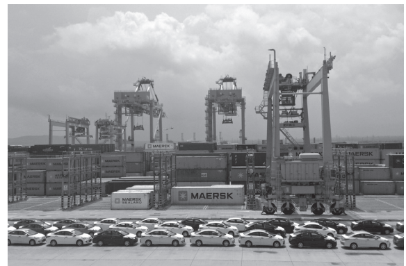
図2 バタンガス港の状況 (2014) 年
